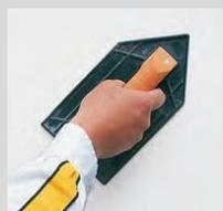
Una vez el producto haya perdido gran parte de agua (transcurridas 5-6 horas aproximadamente según espesor y condiciones de secado), y haya empezado a coger consistencia, fratar la superficie con un frataés con esponja fina.
