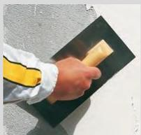
Aplicar **webermur liso** con llana, en una capa de 3 – 5 mm de espesor controlando la planimetría de la misma, y dejar que empiece a secar.
